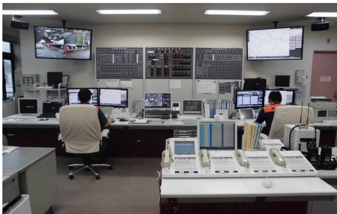
高機能消防指令センター
