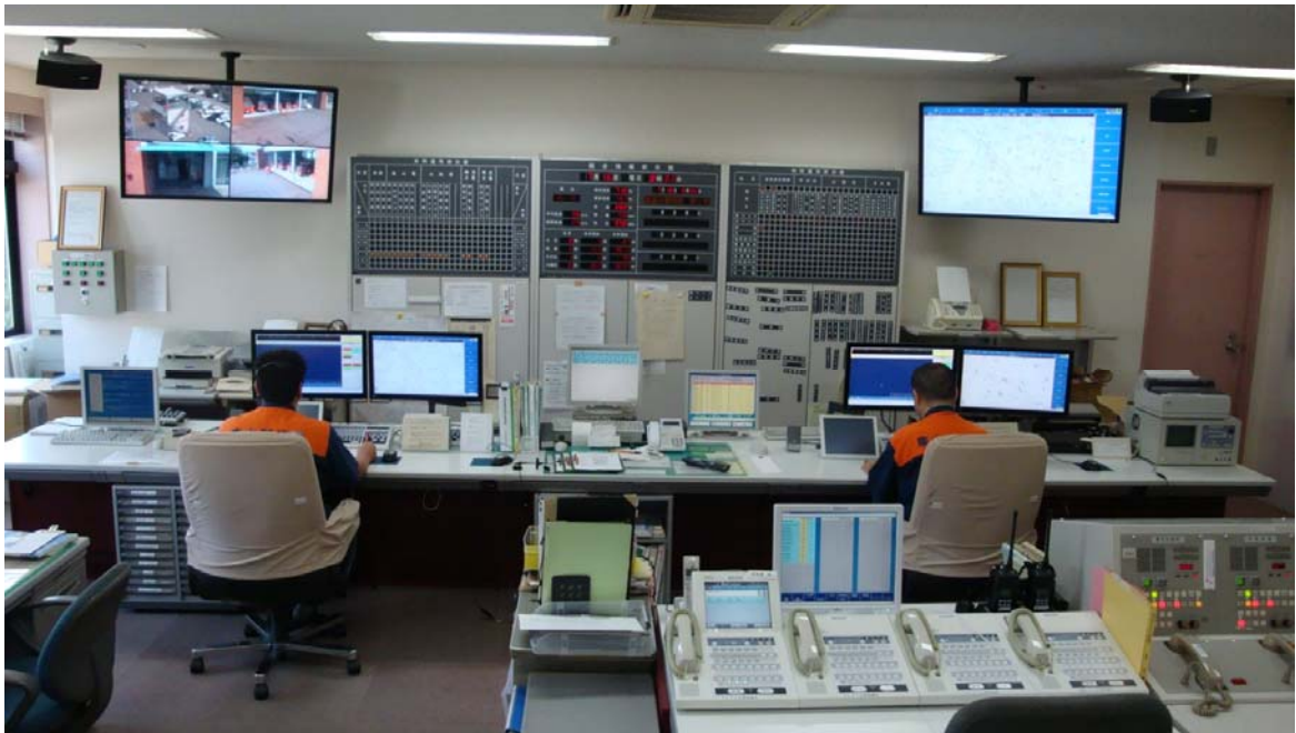
高機能消防指令システム
