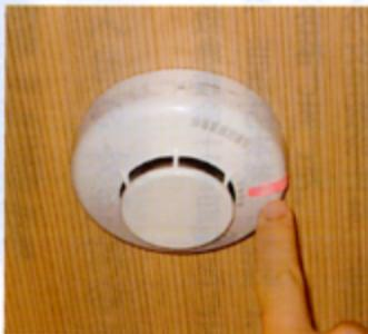
固定した取り付けベースに警報器を取り付けたら、作動試験を行い、正常に作動しているかテストしましょう。
